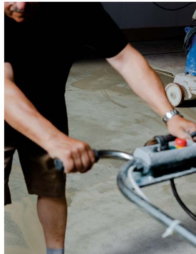
LEVIGATURA DELLA SUPERFICIE / SURFACE SANDING
