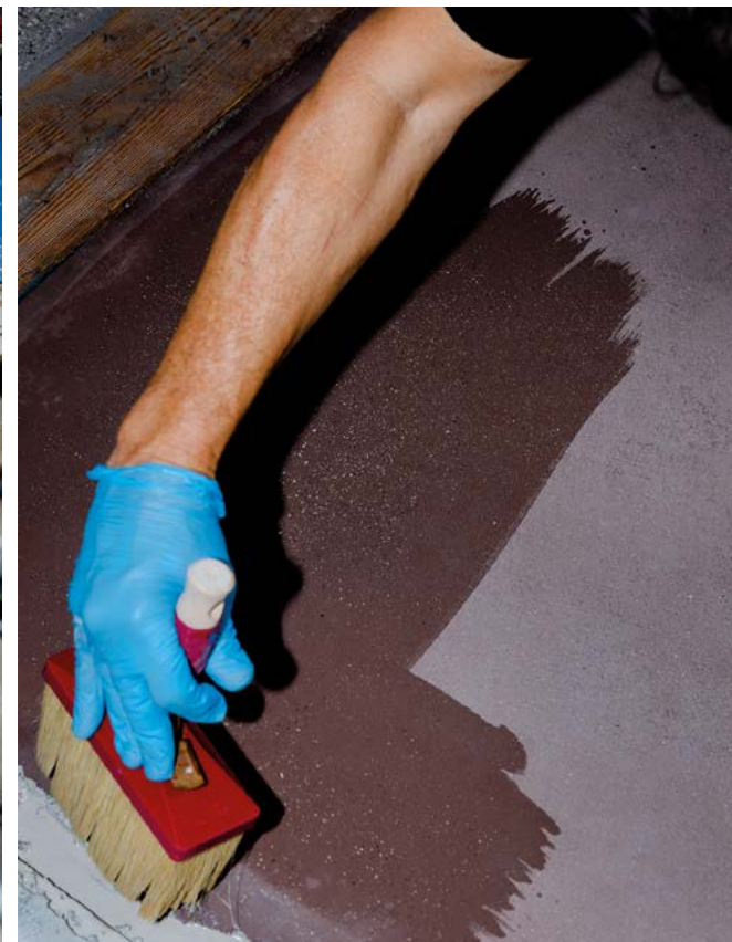
TRATTAMENTO IDROREPELENTE / WATER-REPELLANT TREATMENT
